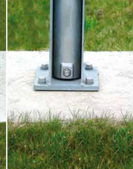
Betonfundament mit Kiphalterung KA.
