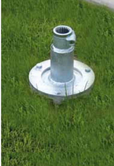
Maschinenadapter, aufgeschraubt auf das Schraubfundament
