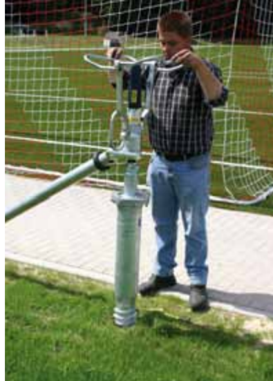
Einschrauben des Schraubfundamentes.
