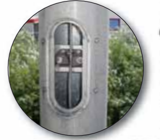
Hissvorrichtung innen, wartungsbedürftig.
